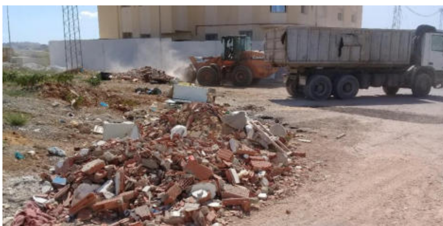
Figure 21: Site n°2 – Commune Mnihla - Zone industrielle –
