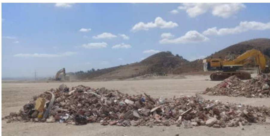
Figure 24: Déchets de chantiers bruts du site 2 de Mnihla avant l'opération de tri
