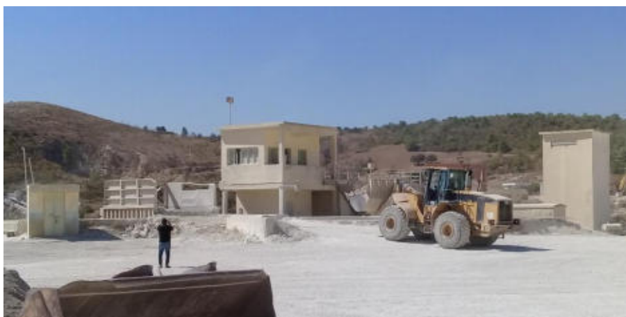
Figure 30: Transport des déchets inertes obtenus après le tri vers la station de concassage équipée en amont par des grilles fixes de scalpage
