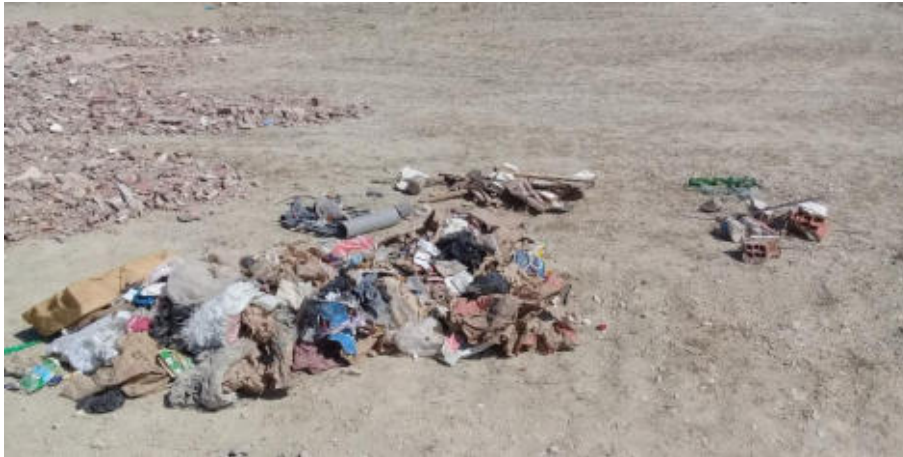
Figure 27 : Déchets divers (ménagers, métalliques, organiques, plastiques, cartons, emballages, verres, bois, plâtre, etc.) éliminés des déchets de chantiers bruts
