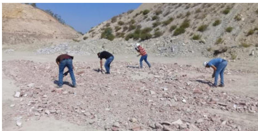
Figure 25: Opération de tri manuel des déchets de chantiers bruts des sites 1 et 2 de Mnihla
