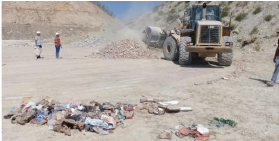
Figure 28: Déchets divers (ménagers, métalliques, organiques, plastiques, cartons, emballages, verres, bois, plâtre, etc.) éliminés des déchets de chantiers bruts
