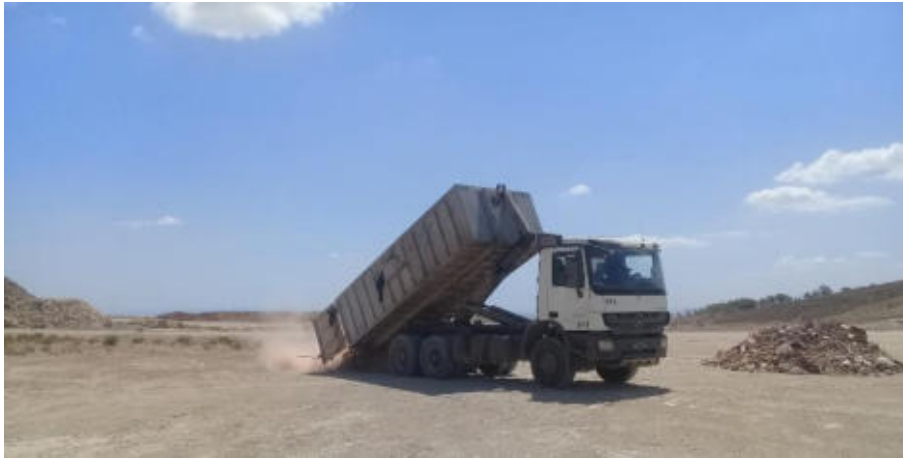
Figure 22: Transport des 24 m 3 des déchets de chantiers des sites 1 et 2 de la commune de Mnihla vers la carrière en exploitation (Société SONAFIC Carrière Naili Fils et Cie) à l'Ariana équipée d'une unité de concassage.
