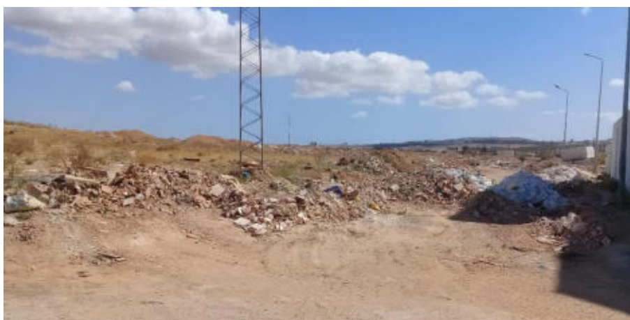
Figure 20: Site n°2 – Commune Mnihla - Zone industrielle – Déchets de chantiers déversés sans autorisation
