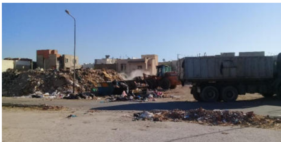
Figure 19 : Site n°1 – Commune Mnihla - Zone d'habitation – Enlèvement de 12 m3 de déchets de chantiers pollués par des déchets ménagers
