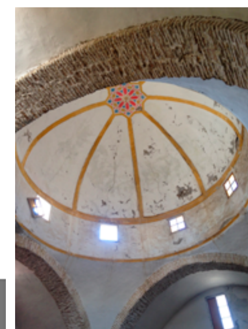
Restauration de la grande Salle de Hammem El Bey à Mohamedia
