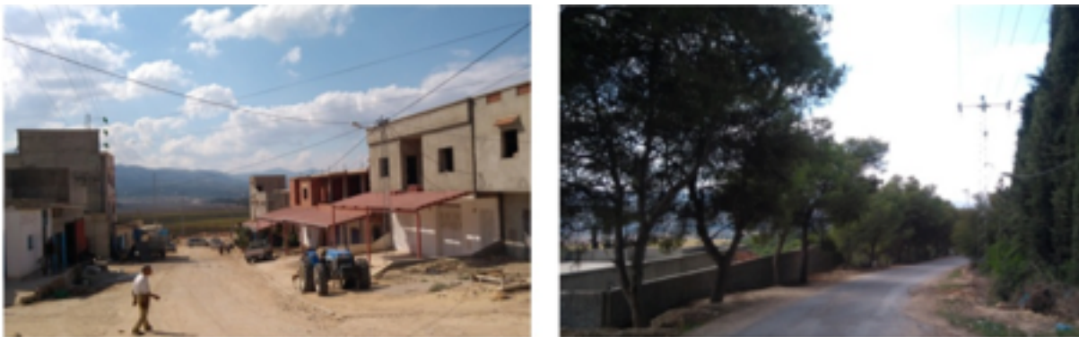
Figure 9 : Entrée Sud et Nord-Est de Thibar
