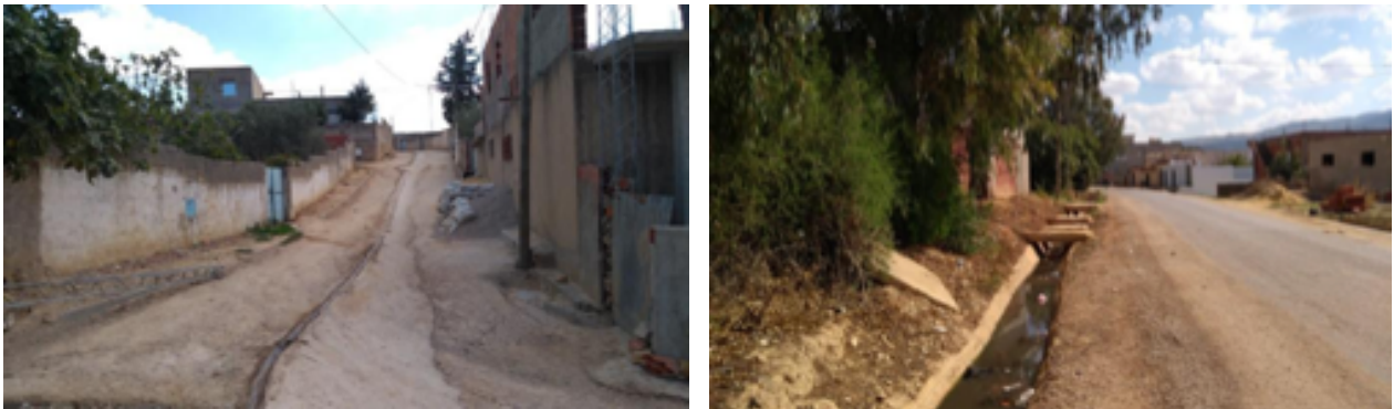
Figure 18: Pendant les saisons pluviales, certaines zones de passages et ruelles deviennent des zones de prolifération à cause de l'eau pluviale stagnante ; une absence totale de réseau d'évacuation.
